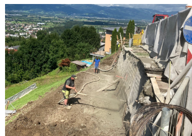
Hangsicherung mit Stahlanker
