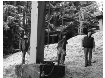
Lift Rollenbatterie Seilzug
